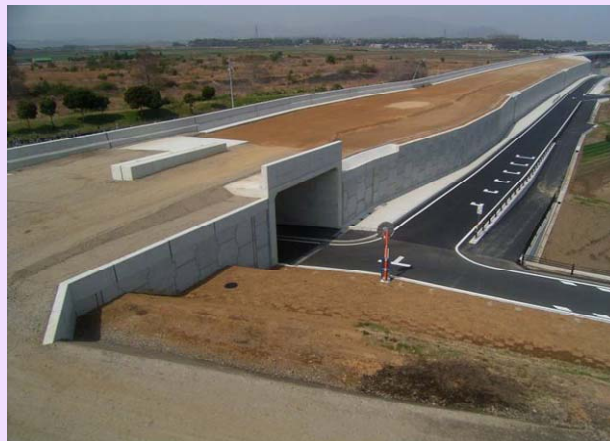
本線及び東側側道部
