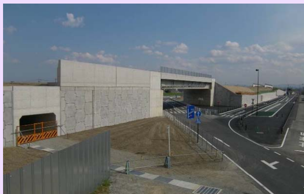
工事起点より
