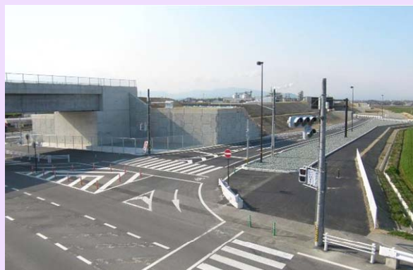
工事終点より
