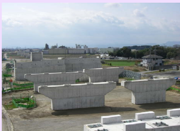
橋台・橋脚部
