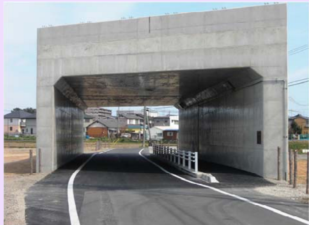
場所打函渠工(25号線)
