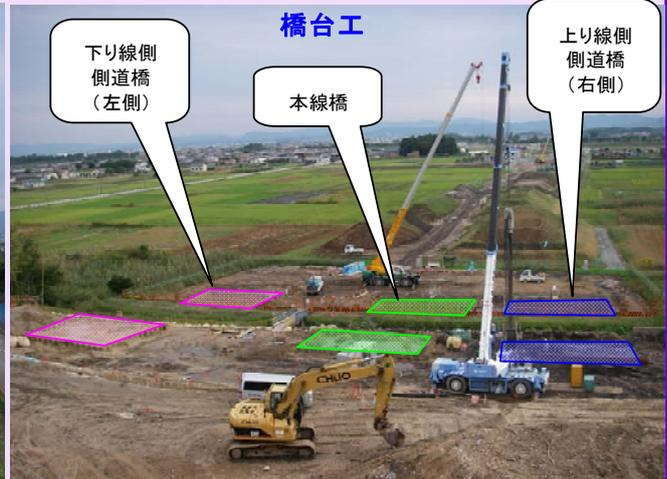
雲出用水を渡る橋を作るための鋼矢板の締切が今月前半で完了となります。随時、南側より構造物の施工に着手していきます。
