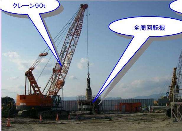
舞出避溢橋の橋台・橋脚を作っています。現在、杭の施工を行っています。直径が1.2m深さが約30m程あります。
