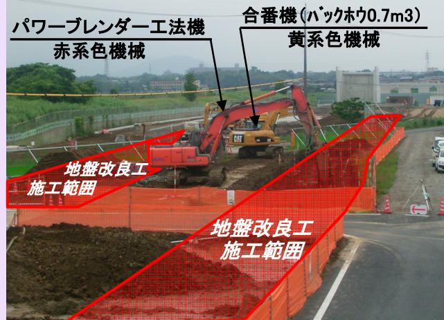
本線盛土および擁壁工の施工に伴い、地盤が軟弱なため、地盤改良を行っています。
