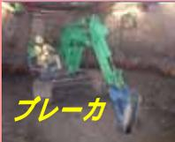
基礎支持層は軟岩(固結シルト)です。ブレーカで地盤を割り、ショベルで積込して、沈下掘削を行いました。
