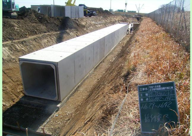
本線橋下部工事は足場撤去のみです。側道橋下部工事は完了しました。ボックスカルバート工事は製品を布設して土砂埋戻しを行います。3月の主な工事はボックスカルバート工事の残り(約50m)です。3月28日で工事完成です。
