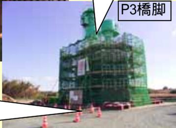
できあがった基礎の下(地下)を掘って沈めます。その繰り返し作業で造ります。
