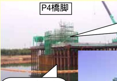
写真で見える部分(地上)で鉄筋コンクリートの基礎を造ります。
