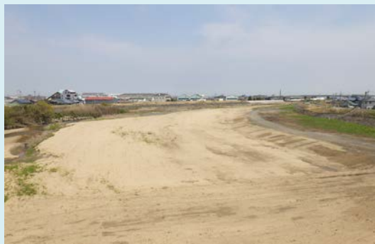
令和2年5月（完成）
