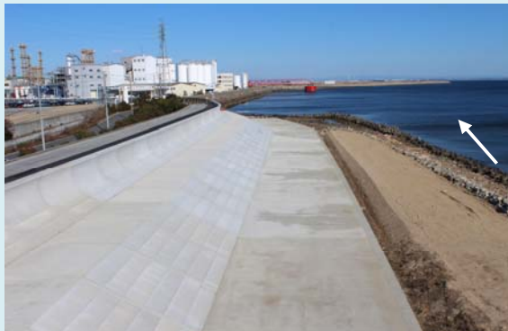
川裏堤防法尻補強工事 (H28.12完成)
