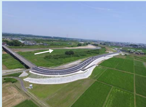
築堤護岸工事 (H29.3完成)
