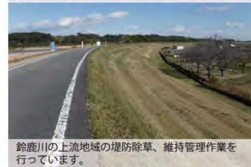
⑩ 平成 26 年度鈴鹿川上流部堤防維持管理工事
