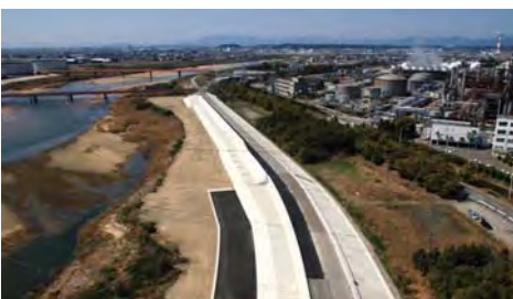
⑨ 平成 26 年度 鈴鹿川石原高潮堤防工事 (左岸 1.0k 付近、四日市市石原町)
