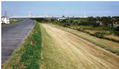
⑫ 平成 25 年度 鈴鹿川下流地域堤防維持管理工事
