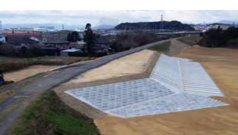
⑤ 平成 26 年度 鈴鹿川派川上水道取水施設撤去工事 (右岸 3.8k 付近、四日市市楠町南川)
