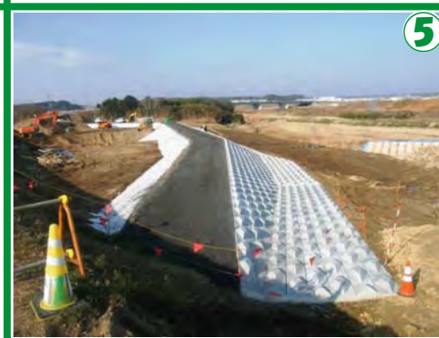
⑤ ①平成26年度 鈴鹿川派川上水道取水施設撤去工事 ②諸岡建設(株) ③H26.9.5 ~ H27.3.13 ④堤防の下に埋められている不要となった上水道管の撤去工事を、四日市市と共同で行っています。
