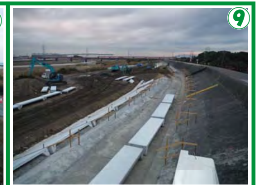
⑨ ①平成26年度 鈴鹿川石原高潮堤防工事 ②信藤建設(株) ③H26.9.27 ~ H27.3.13 ④高潮時の潮位上昇対策として、堤防を高くする工事を行っています。
