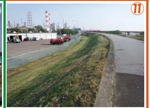
⑪ ①平成25年度 鈴鹿川下流地域堤防維持管理工事 ②信藤建設(株) ③H26.3.28 ~ H27.3.31 ④鈴鹿川の下流地域の除草、日々の維持管理作業を行っています。
