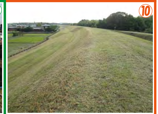
⑩ ①平成25年度 鈴鹿川上流地域堤防維持管理工事 ②西口建工(株) ③H26.3.26 ~ H27.3.31 ④鈴鹿川の上流地域の除草、日々の維持管理作業を行っています。
