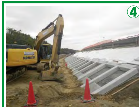
④ ①平成26年度 鈴鹿川甲斐築堤護岸工事 ②(株)服部組 ③H26.6.26 ~ H27.2.27 ④堤防を強くするため、堤防の幅を広くしコンクリートで保護する工事を行っています。
