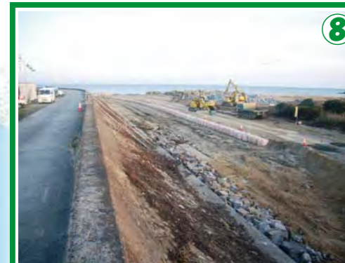
⑧ ①平成26年度 鈴鹿川派川北五味塚高潮堤防工事 ②(株)中村組 ③H26.7.4 ~ H27.3.31 ④高潮時の潮位上昇対策として、堤防を高くする工事を行っています。
