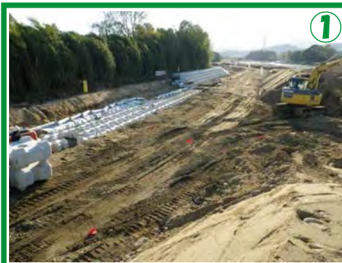
① ①平成26年度 鈴鹿川地区木下根固設置工事 ②(株)杉本組 ③H26.6.24 ~ H27.2.27 ④護岸の洗掘防止目的で、根固用のコンクリートブロックを設置しています。
