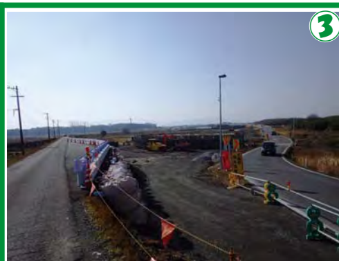
③ ①平成26年度 鈴鹿川平野築堤護岸工事 ②(株)杉本組 ③H26.9.4 ~ H27.3.31 ④堤防の嵩上げ(兼用道路も合わせて)を三重県と共同で行っています。
