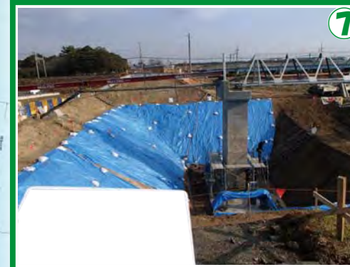
⑦ ①平成26年度 鈴鹿川派川四日市工業用水道水管橋耐震補強工事 ②勢州建設(株) ③H26.8.19 ~ H27.3.13 ④鈴鹿川を横断する工業用水管橋の耐震補強工事を三重県企業庁と共同で行っています。
