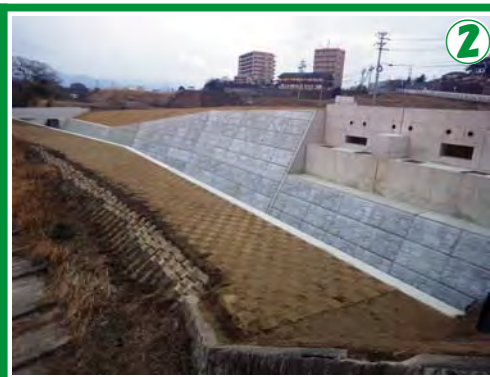
② ①平成25年度 鈴鹿川鹿島橋左岸下部工事 ②堀田建設(株) ③H25.9.21 ~ H27.1.9 ④鈴鹿川を横断する鹿島橋の架け替え工事の一環で、橋台下部工事を行っています。
