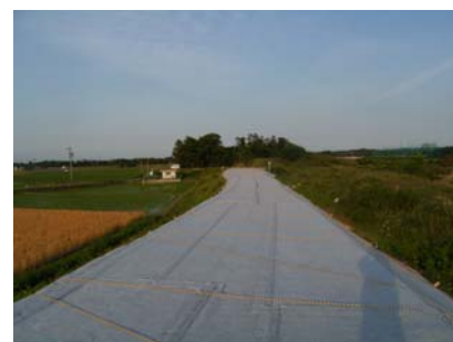
井尻地区での工事完了
