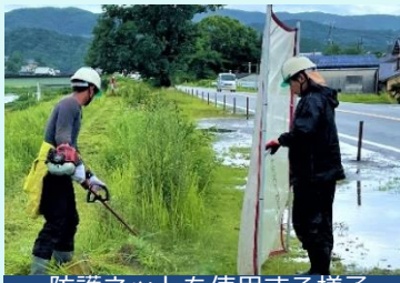
防護ネットを使用する様子
