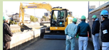
安全パトロールの様子
