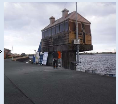
勢田川右岸 通排水ひ門
