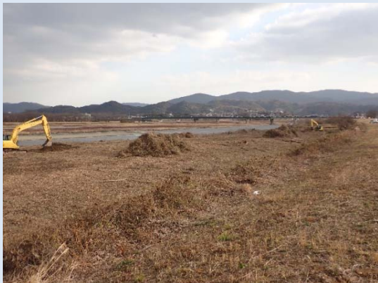
樹木の伐採 宮川左岸 小俣町付近
