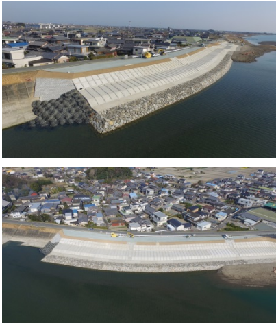
平成27年度 宮川西豊浜地区築堤護岸工事 (株)山野建設
