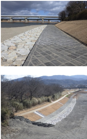
平成28年度 宮川中島築堤護岸工事 宮本建設(株)
