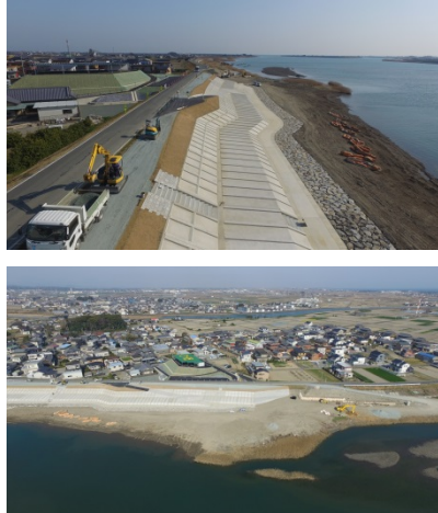
平成28年度 宮川西豊浜築堤護岸工事 (株)山野建設
