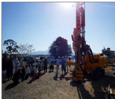
削孔機で地面を計画深度まで削孔を行います。
