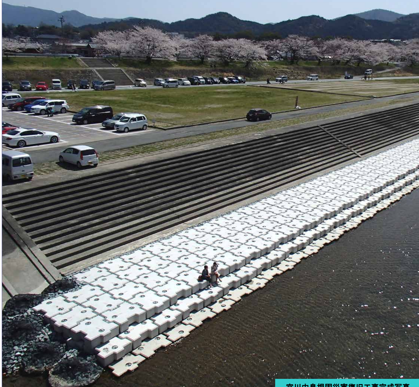
宮川中島根固災害復旧工事完成写真
