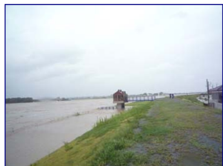
堤防箇所出水時の状況 (宮川右岸・伊勢市辻久留地区)
