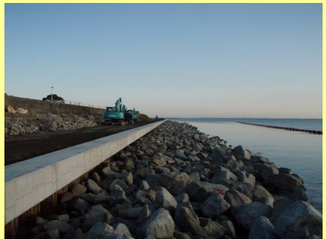
高潮護岸施工状況
