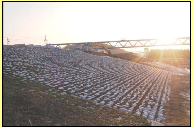
築堤護岸施工状況
