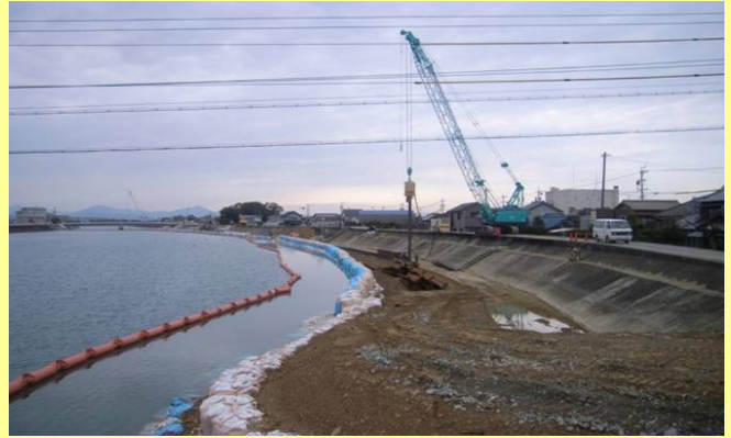
鋼矢板打設状況
