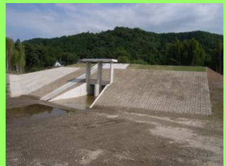
小田古川排水樋門
