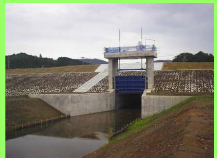
大倉川排水樋門
