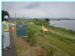
除草作業状況
