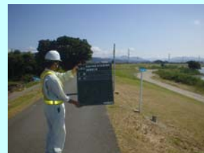
除草作業完了
