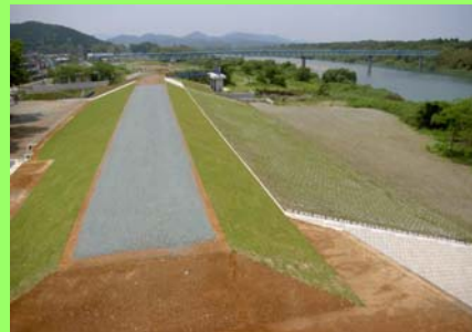
大倉工区 完成
