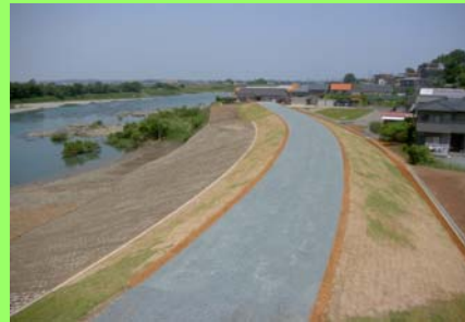
辻久留工区 完成
