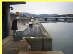
護岸補修工事
