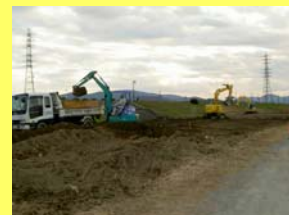
河川敷整正工事
