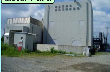
桧尻排水機場
