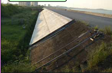
補強コンクリート
