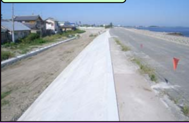
補強コンクリート完了
