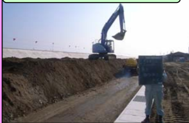
現在の作業(覆土敷均し作業)
