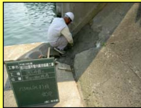
護岸補修工事
