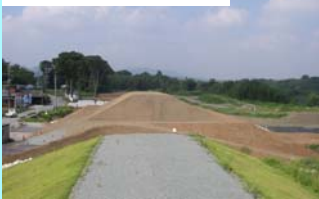
全景（先行盛土状況）
