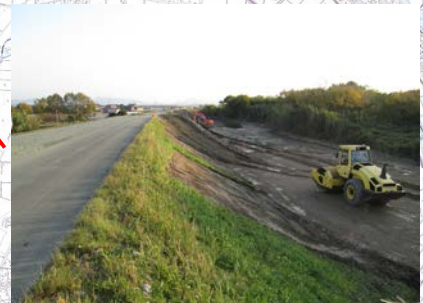
櫛田川右岸4.9～5.5k付近 平成28年11月22日撮影
