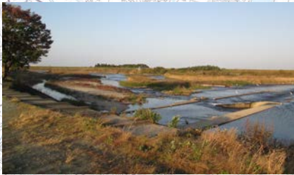
櫛田川左岸2.5～2.9k付近 平成28年11月22日撮影
