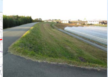
櫛田川右岸2.5～2.9k付近 平成28年11月22日撮影
