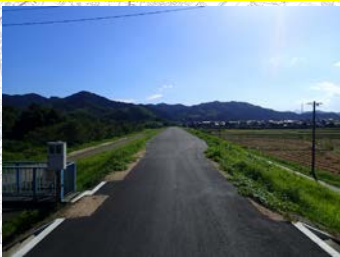
櫛田川左岸16.6k付近 平成28年8月31日撮影
