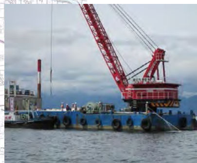
②ケーブル撤去を行いました (明和町浜田地先)
