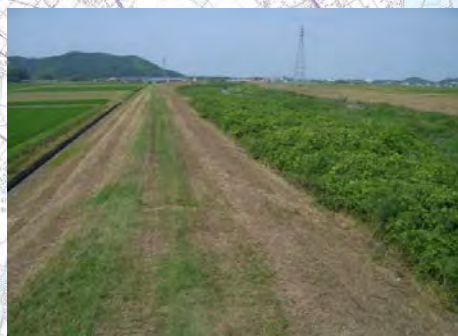
①堤防除草を行いました (櫛田川・佐奈川 管内全域)
