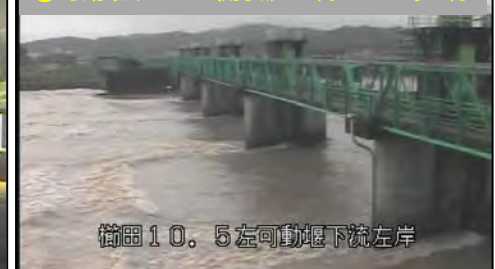
③可動堰ゲート全開状況 8月26日6時06分
