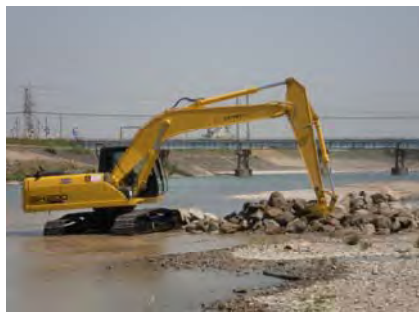
重機で大石を積み込んで……
