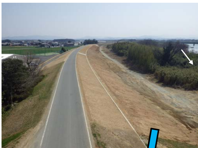
④ 櫛田川右岸4.0k付近 松阪市魚見町 工事延長389m
