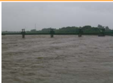
洪水操作中の櫛田可動堰
