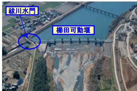
祓川水門と櫛田可動堰の遠景
