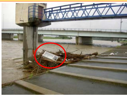
台風6号で櫛田橋水位観測所に流れ着いた冷蔵庫
