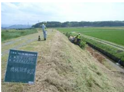
法面や平場は自走式の機械を用います
