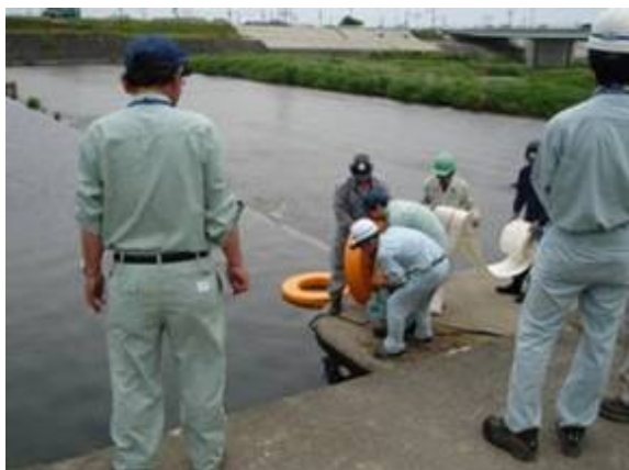
排水ポンプ設置作業
