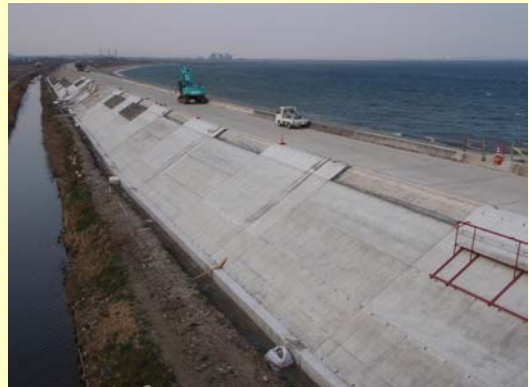
松名瀬堤防 No.93付近
