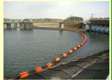
可動堰網場ゴミ処理
