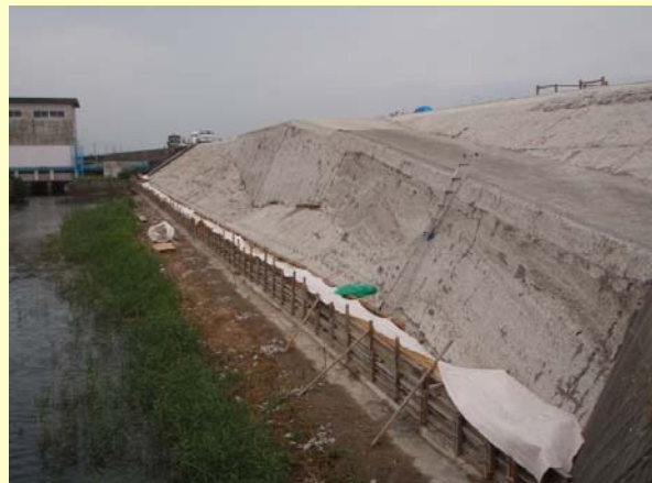
松名瀬堤防 No.93付近
