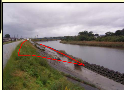
松名瀬工区予定箇所(右岸)
