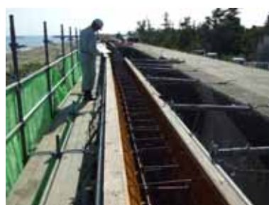
(工事監督状況)
