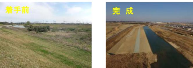
工事は、中村川下流部において、洪水時の水位を下げて、安全に洪水を流下させることを目的として、河川の堆積土を掘削し、川の断面を拡げました。
