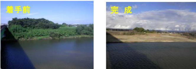
工事では、洪水時の水位を下げて、安全に洪水を流下させるため、河川の堆積土を掘削し、川の断面を拡げるとともに、流れの支障となる樹木の伐開を行いました。
