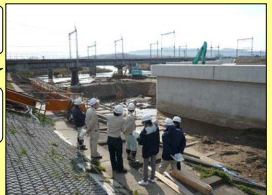
特定構造物改築事業 (近鉄中村川橋梁)
