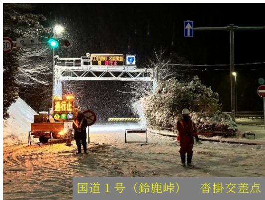
通行止めの状況
