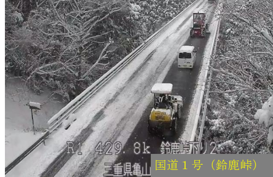
グレーダーとロードショベルを併用した除雪
