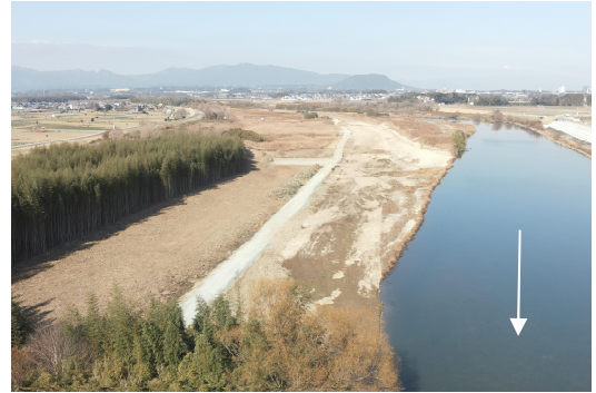
須賀瀬地区 河道掘削
