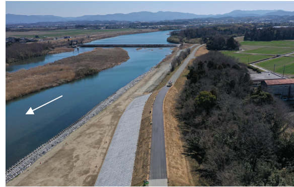
清水地区 築堤護岸整備
