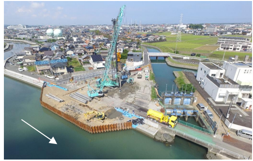
船江地区 桧尻川排水機場ポンプ増強
