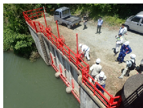
出水期前点検状況
