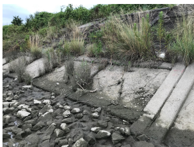
< 損傷箇所の補修 >
