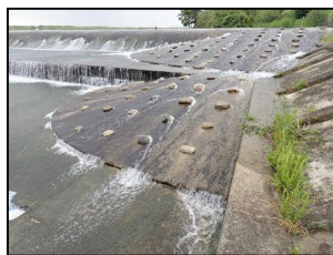
榑田第二頭首工 左岸斜路式魚道 (令和4年度 設置)
