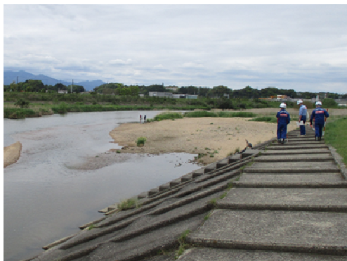
堤防徒歩点検状況
