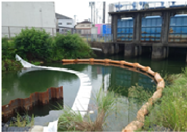
水質事故対応 常設オイルフェンス（オレンジ色）に加え万国旗型オイル吸着マット（白色）を設置
