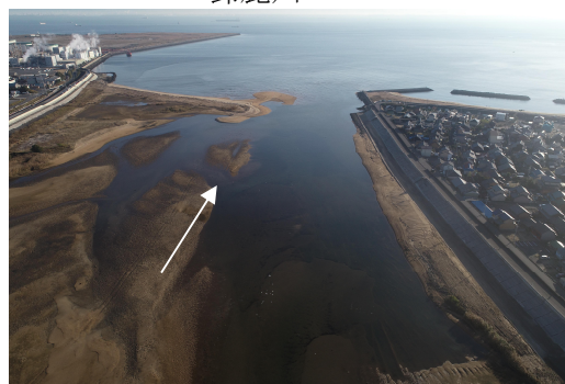
塩浜地区 河道掘削
