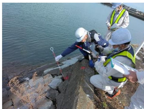
堤防徒歩点検状況
