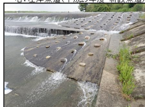
櫛田第二頭首工 左岸斜路式魚道 (令和4年度 設置)
