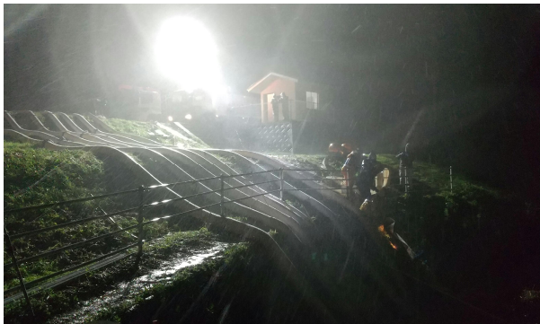
令和2年7月豪雨（排水作業） 福岡県久留米市における排水ポンプ車の派遣
