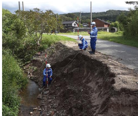
踏査による被災路線調査状況
