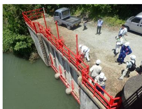
出水期前点検状況
