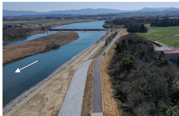
清水地区 築堤護岸整備
