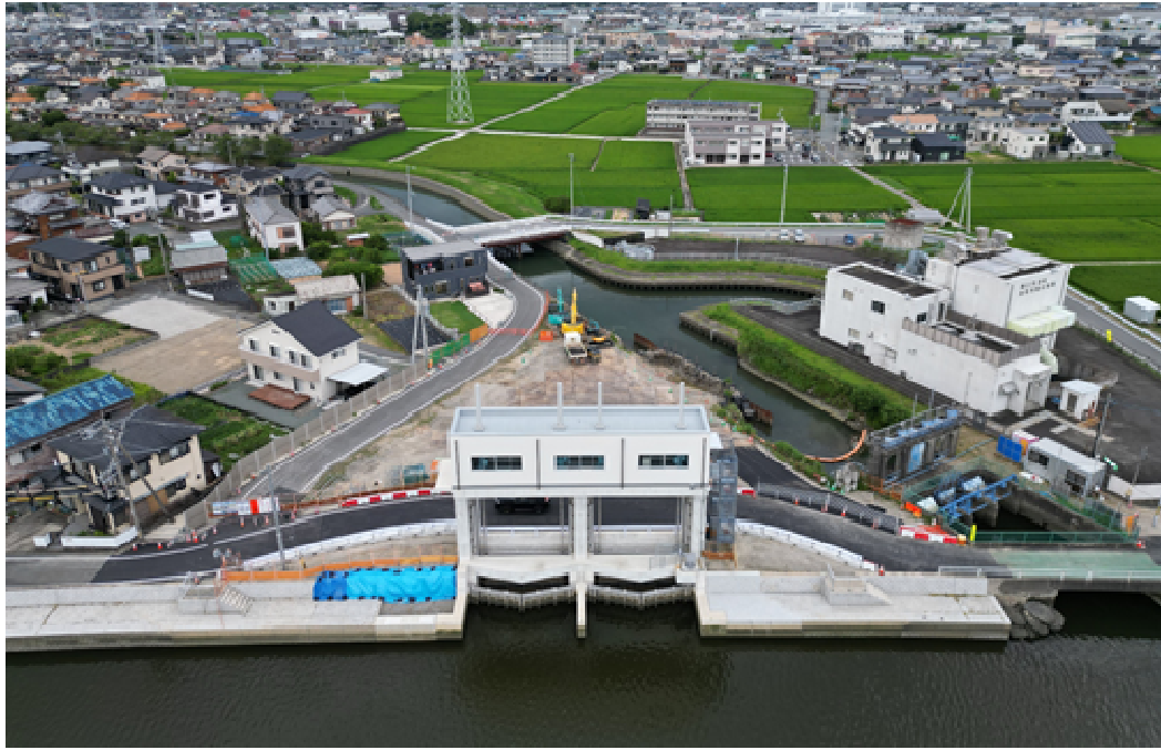
新松尾川樋門整備の状況（R6.7）
