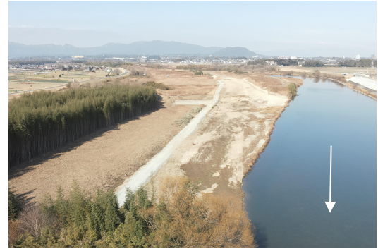
須賀瀬地区 河道掘削
