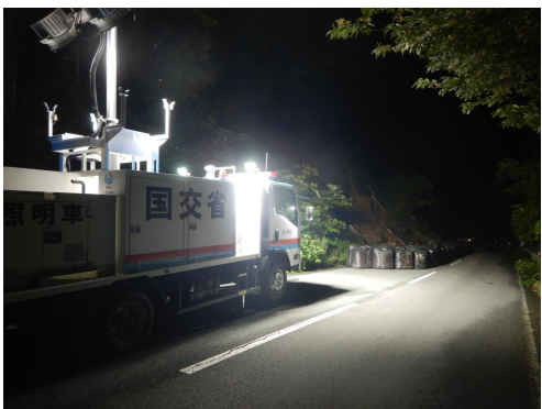
令和6年6月法面崩落（照明作業） 三重県伊勢建設事務所における照明車の派遣
