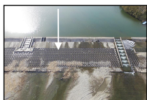
新屋敷取水堰 魚道 左: 中央魚道(平成28年度 改良魚道) 右: 左岸魚道(平成29年度 新設魚道)
