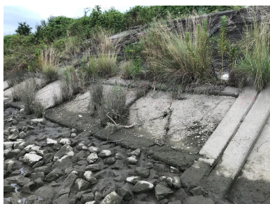
＜損傷箇所の補修＞
