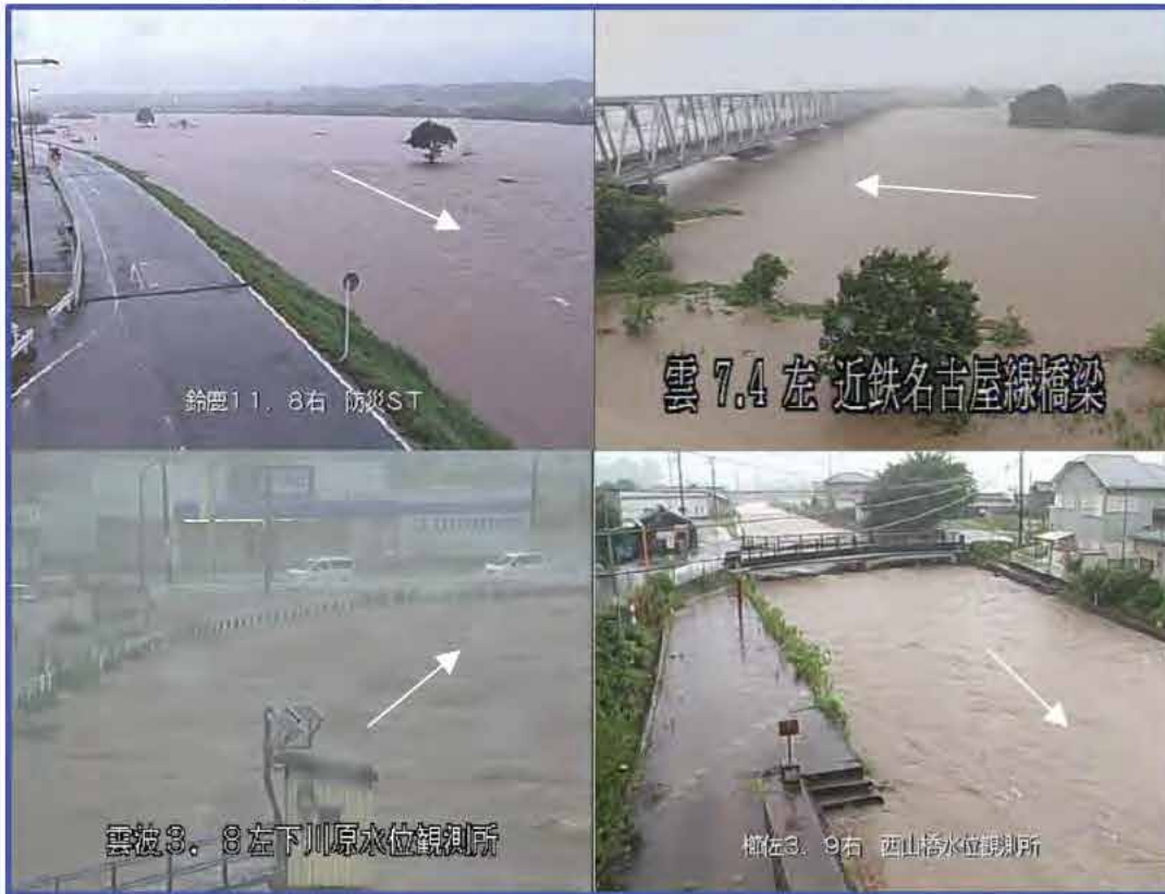
雲出川支川 波瀬川(3.8k左岸) 9日16:20 津市一志町井関地先
