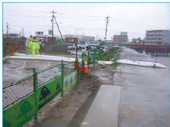
津市(江戸橋第二排水機場) の活動状況
