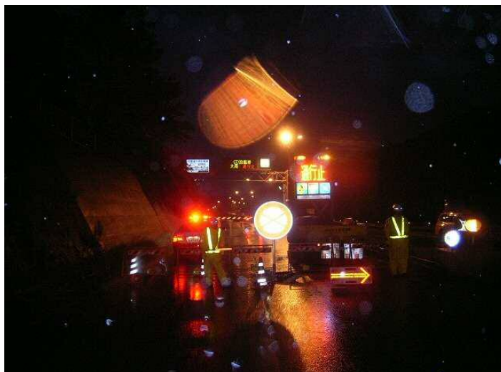
【国道1号鈴鹿峠通行止め状況】(土山ゲート 433.9kp)
