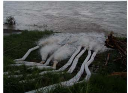
汁谷水門 (排水ポンプ稼働により家屋浸水を防ぐ)
