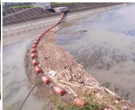
9月22日 9:40 網場による流木補足状況
