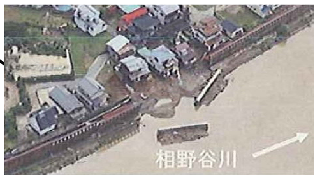
相野谷川(紀宝町)堤防崩壊
