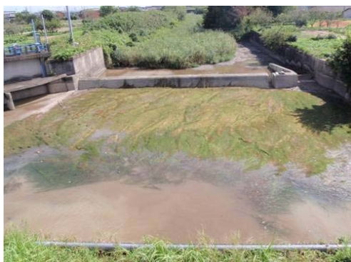
9月22日 9:30 祓川一部開放前の状況
