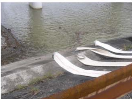
御浜町志原 (排水ポンプ設置状況)
