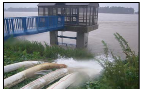
辻久留4号排水樋管付近 (排水ポンプ稼働により家屋浸水を防ぐ)
