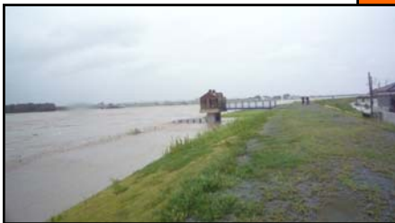
堤防整備箇所の出水時の状況(宮川右岸:伊勢市辻久留地区)
