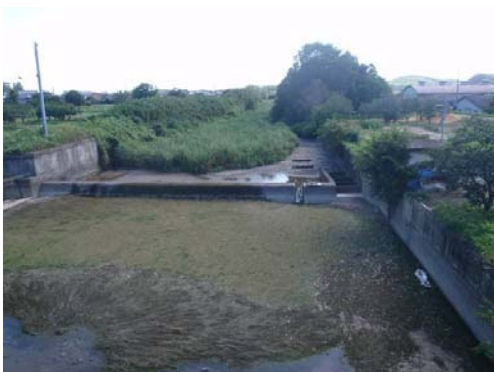
9/6 9:15 祓川一部開放前の状況
