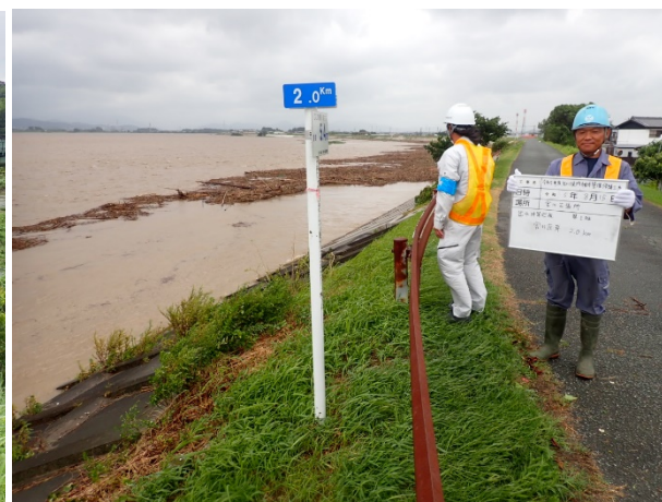
宮川左岸2.0k 付近
