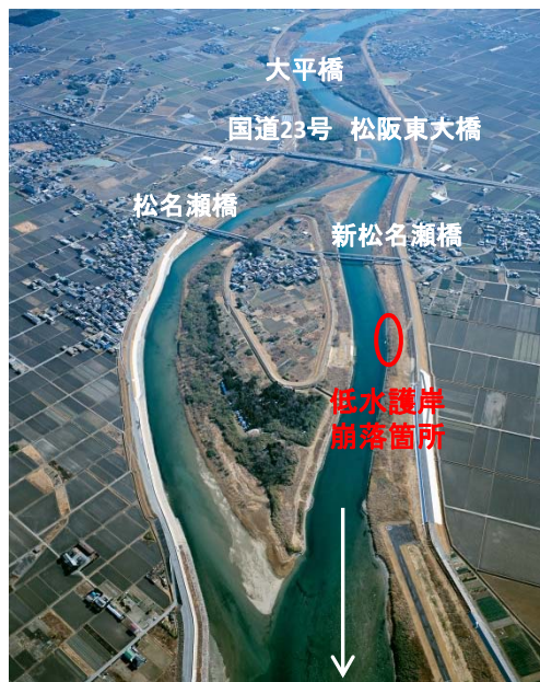
橿田川 被災箇所
