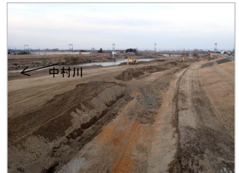
河道掘削実施状況
