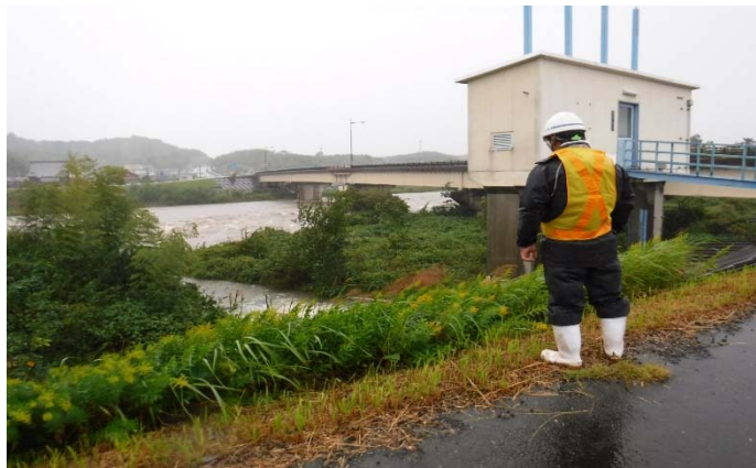
櫛田川 新両郡橋
