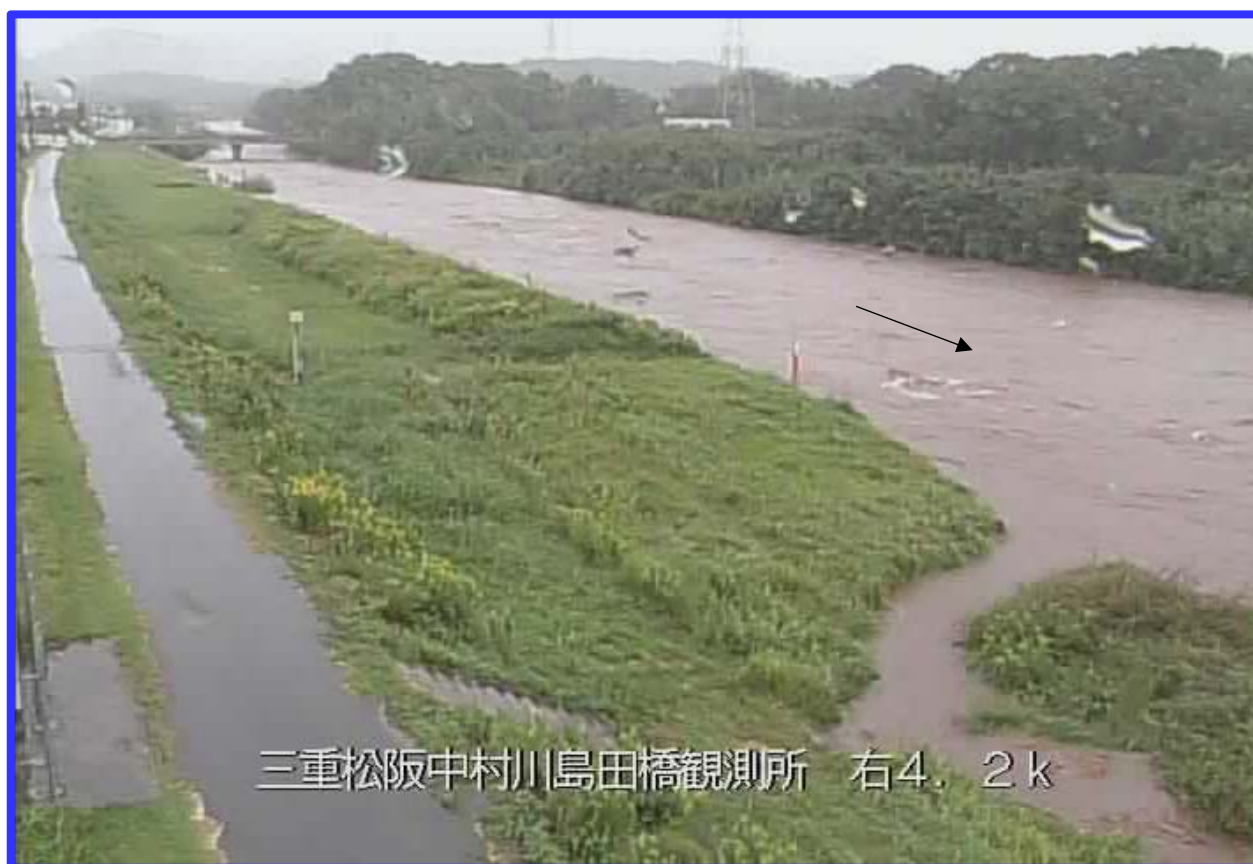
雲出川水系 中村川 右岸4.2k 島田橋水位観測所 12日 12:00頃
