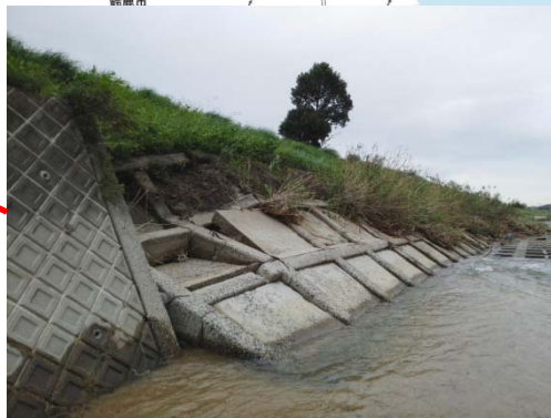
左: 護岸損傷 鈴鹿川左岸27.8k
