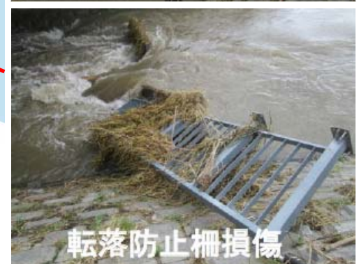
右: 転落防止柵損傷 雲出川 左岸8.2k
