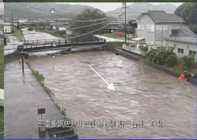
櫛田川支川 佐奈川 西山橋(3.9k右岸) 20日 13時42分 多気郡多気町西山地先
