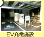
EV充電施設
